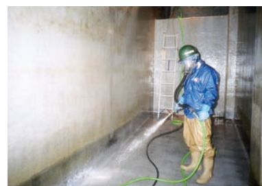
施工イメージ 高圧洗浄
