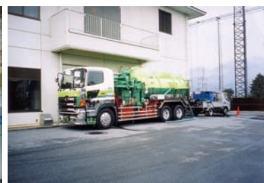
施工イメージ スカム・沈砂除去
