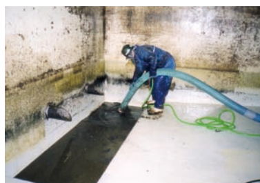
施工イメージ スカム・沈砂除去
