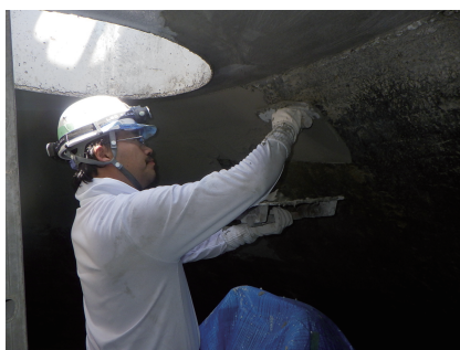
STEP2 躯体補修（耐硫酸性モルタル）
