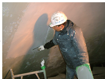
STEP3 素地調整（エポキシ樹脂）
