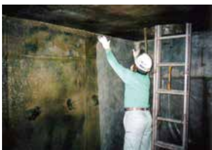
STEP5 サーフェスマット貼付
