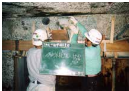
STEP2 躯体補修 (グラウト注入)
