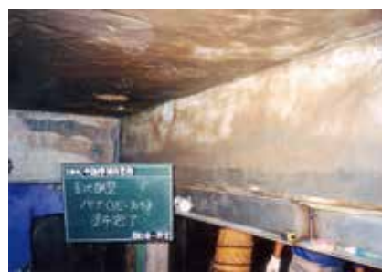
STEP3 素地調整 (FRP パテ)
