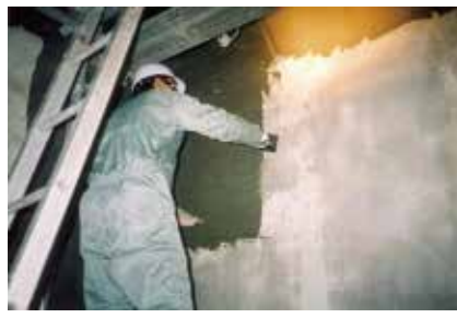
STEP2 素地調整 (水性エポキシモルタル)
