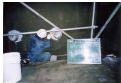
STEP3 躯体補修 (樹脂モルタル)
