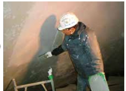
STEP3 素地調整 (エポキシ樹脂)
