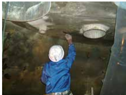
STEP2 躯体補修 (樹脂モルタル)
